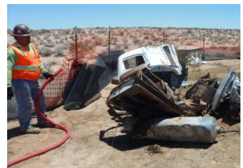
Los trabajadores utilizan agua para controlar el polvo al retirar grandes piezas de automóviles y desechos domésticos.
