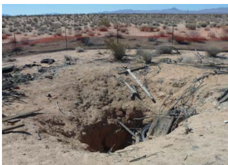
Foto del foso abierto antes de las actividades de limpieza.
